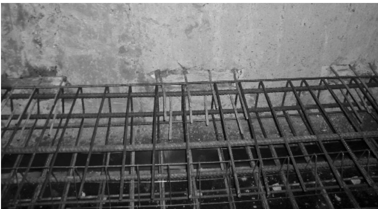
Рис. 4. Узлы соединения перекрытия и ограждения котлована
