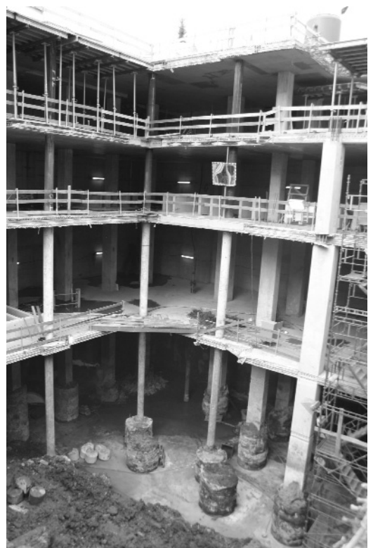
Рис. 5. Устройство временных и постоянных буровых колонн
